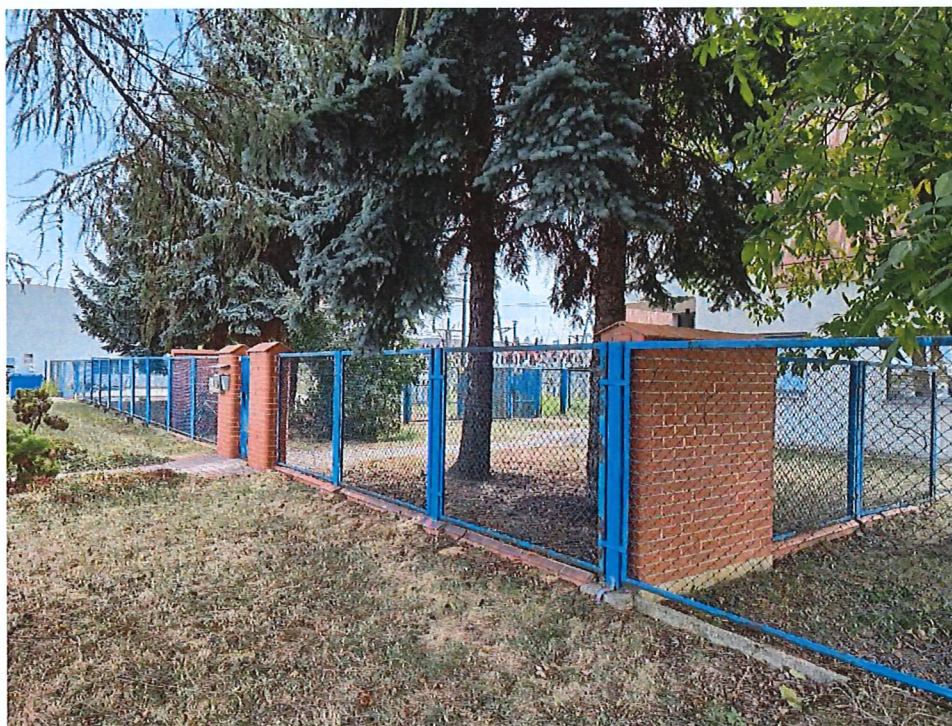
Zdj. 2 – Istniejące ogrodzenie, wejście do budynku
