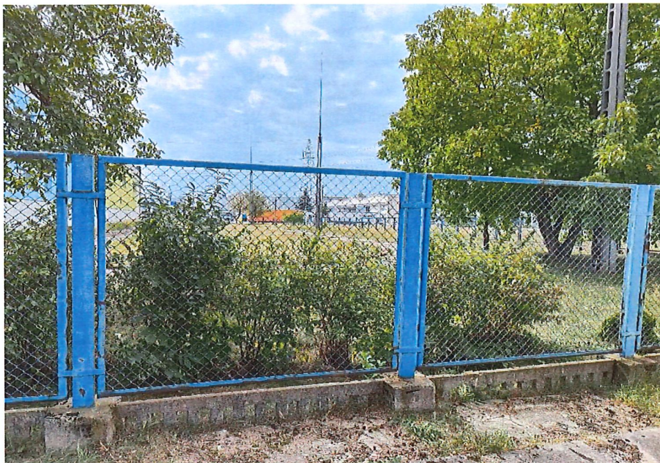
Zdj. 1 – Istniejące ogrodzenie stacji
