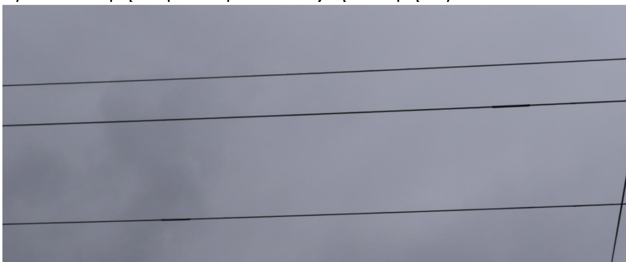
Rysunek 16 Złączki zaprasowywane na fazach R i T przęsło słup nr 3 - słup nr 4, linia 1
