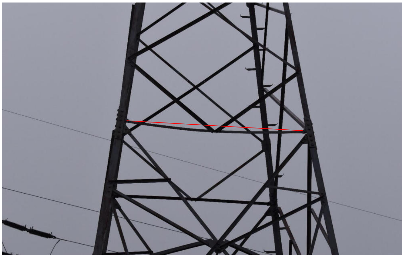
Rysunek 10 Konstrukcja na stanowisku nr 27, linia 1 – wyboczenie skratowania głównego
